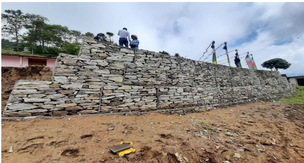
वडा नं. १, कासी गुम्बा ग्याबिन वाल निर्माणको तस्वीर
