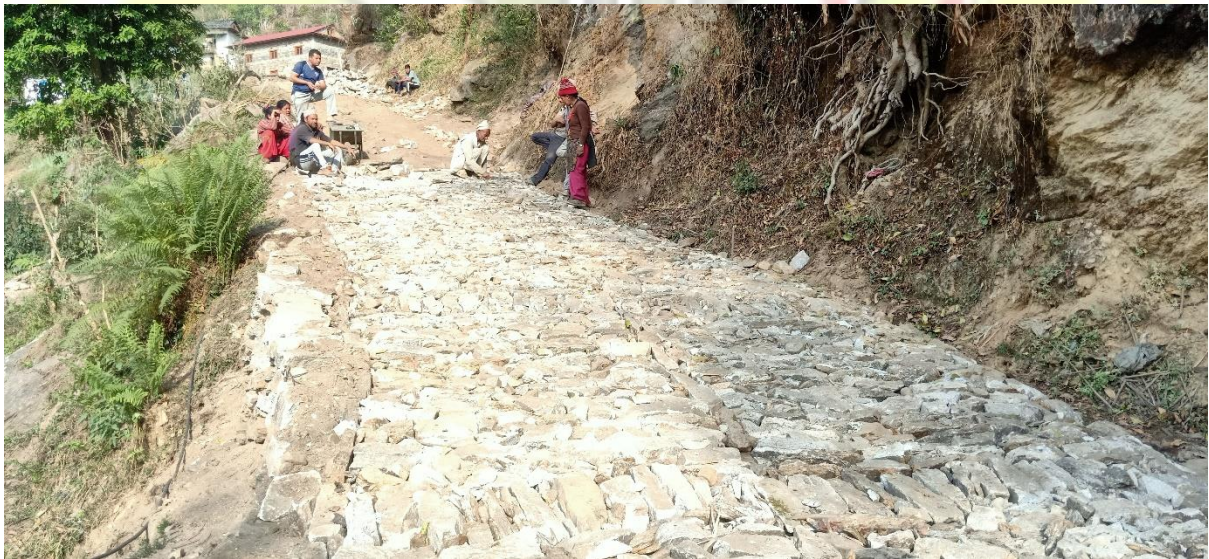
वडा नं २, भिमसेनथान सडक सोलीड
