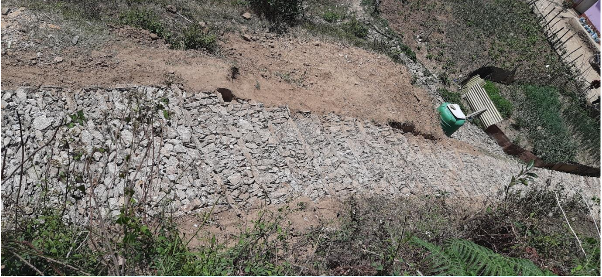
वडा नं ३ मा गोरेटो बाटोको सिढी निर्माण हुदै गर्दाको तस्वीर
