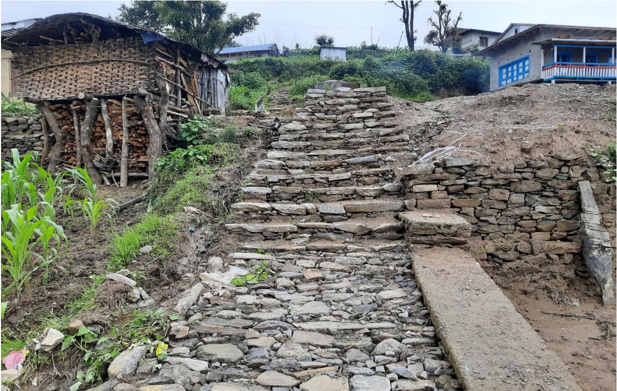
वडा नं. ५, सिढी निर्माण
