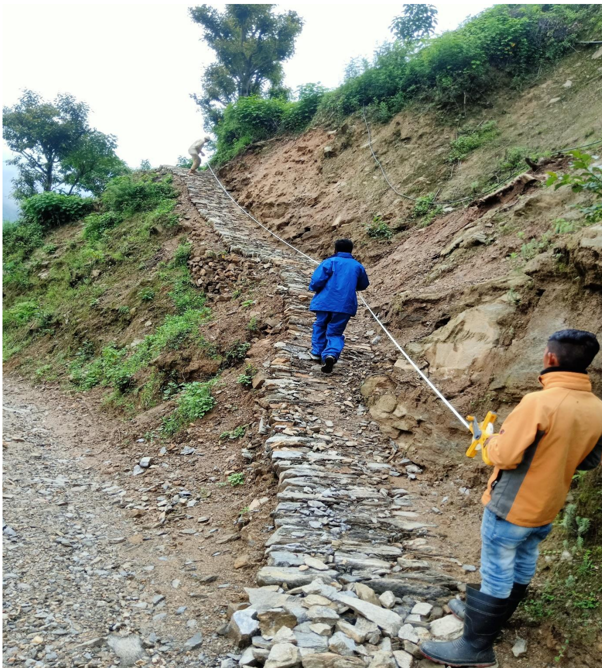
वडा नं ५, गोरेटो बाटो निर्माण पश्चात प्राविधिक नापजाप हुदै
