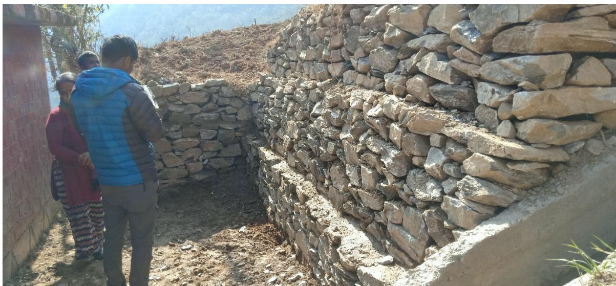
वडा नं ५, सुख्खा वाल निर्माण
