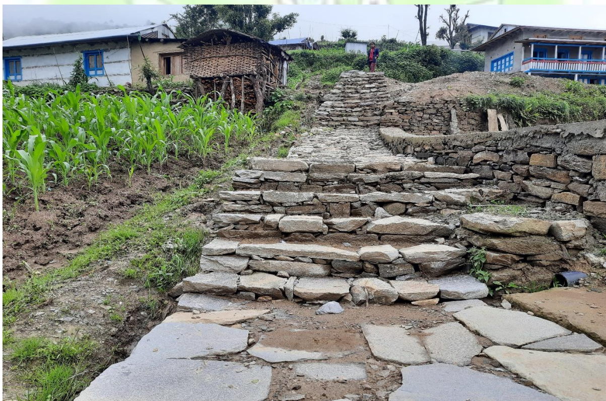
वडा नं ५ सिढी निर्माण
