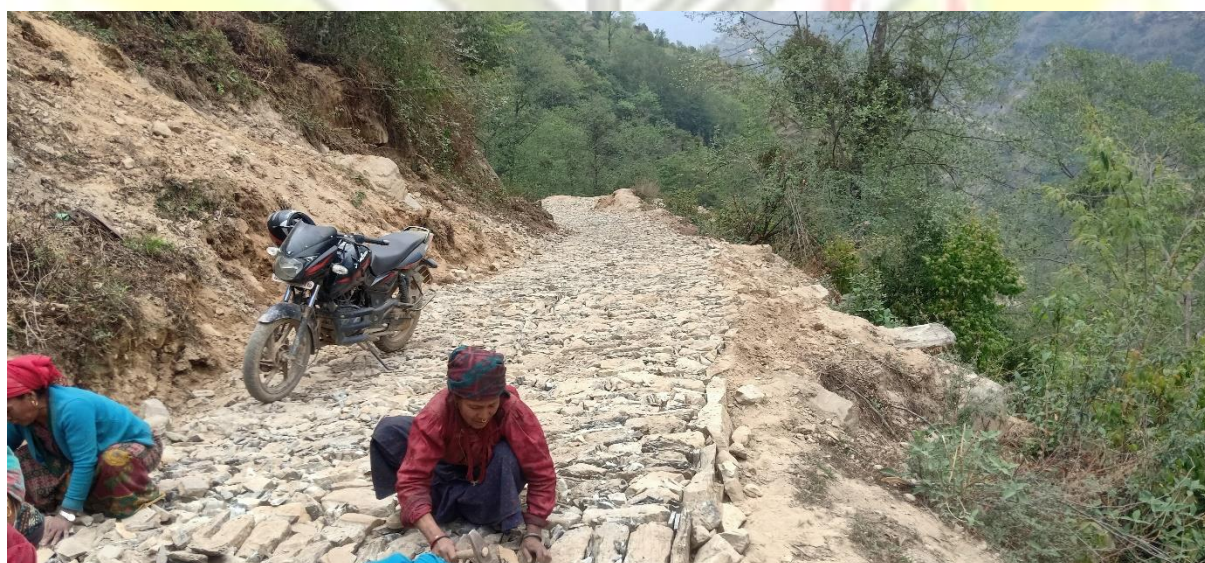
वडा नं. २ मैली, मादालु खण्डमा सडक सोलीडको काम गर्दै महिलाहरु
