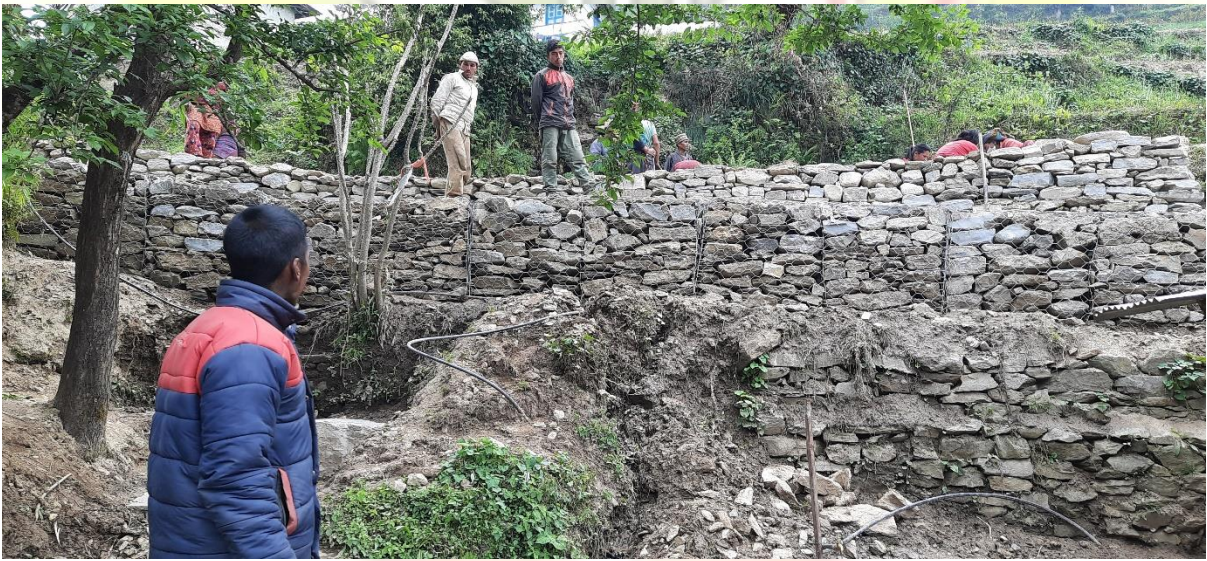
वडा नं. ५ ग्याबिन वाल निर्माण
